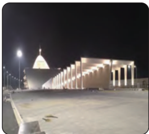
3.珠海港澳大桥东岛监控大厅
